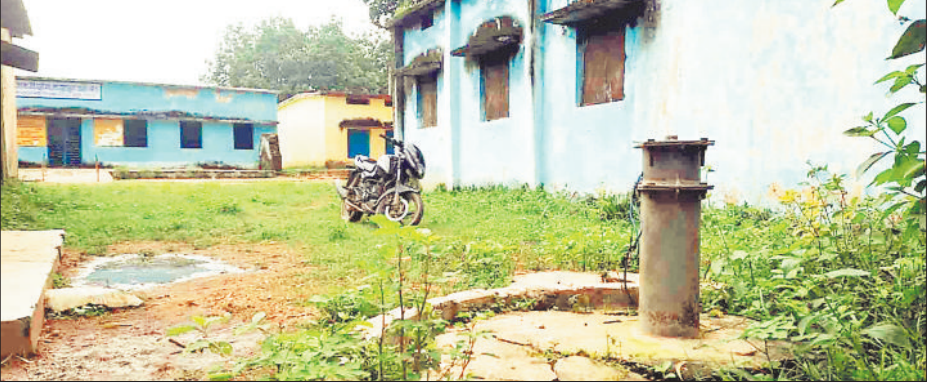
हैंडपंप में लगाया गया सबमर्सिबल ।
